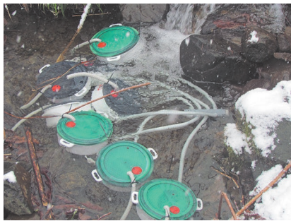
ж) установка гнезд «Шайба 400», кассета 8 шт.
